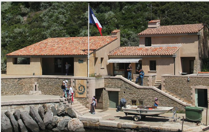
Maison du Parc et Capitainerie (Christel Gérardin - Parc national de Port-Cros)
