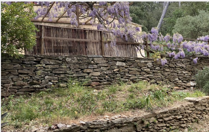
Barrage de Port-Cros (©loane_grasset_PN_PortCros)
